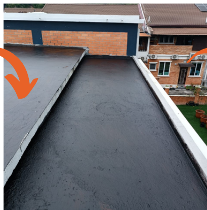
APPLY BITUMEN
